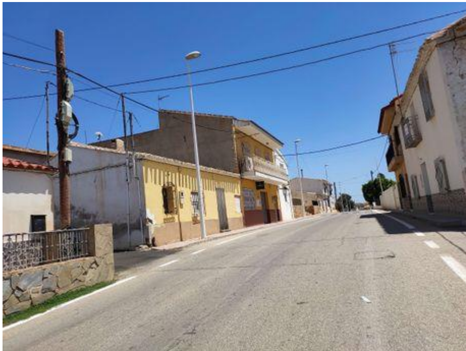
Imagen 24. Ausencia o estrechez de las aceras. Elaboración propia
