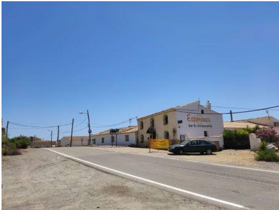
Imagen 25. Estado carretera. Elaboración propia
