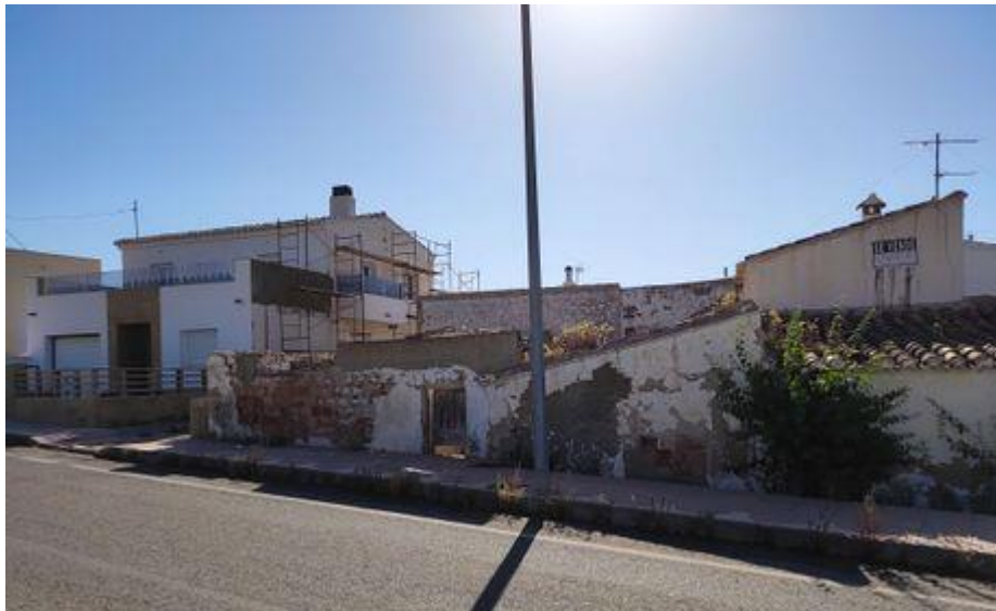
Imagen 2. Viviendas nuevas y derruidas. Elaboración propia
