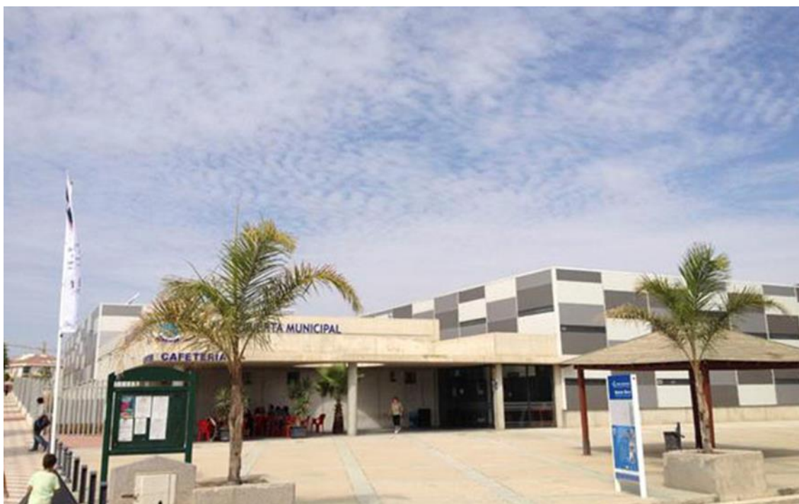
Imagen 10. Fachada centro deportivo H2O
